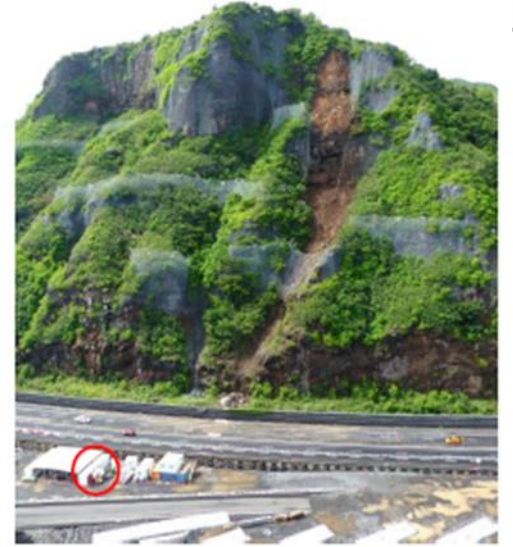
Un évènement chute de blocs
